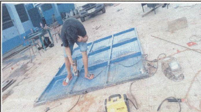
Foto 2: Se aprecia en la foto como se esta reparando el porton principal
