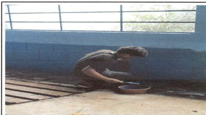
Foto 10: Aquí se puede observar como se va avanzando en el trabajo de pintura del establecimiento.
