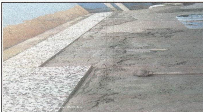
Foto 7: Se da inicio con la colocación de granito en la parte del suelo que se encontraba en mal estado.
