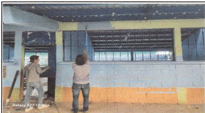
Foto 9: Se inicia con el trabajo de pintura en las paredes del establecimiento.
