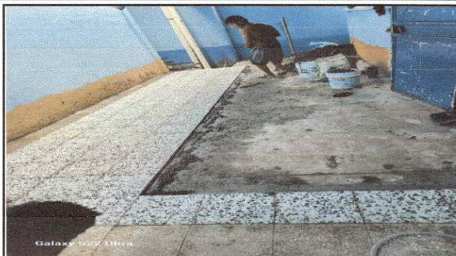
Foto 8: Aquí podemos observar como va avanzando el trabajo en la colocación del granito para mejorar el espacio, que no contaba con el mismo.
