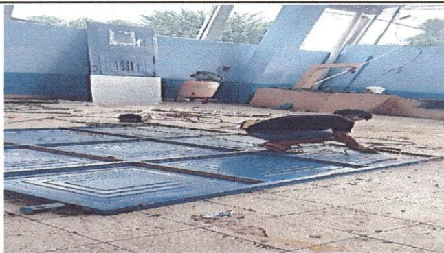
Foto1: Se da inicio con la reparación del porton principal de la escuela
