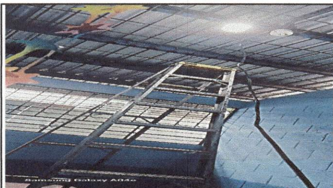
Foto 3: Se inicia con la reparación del sistema electrico y cambio de lamparas
